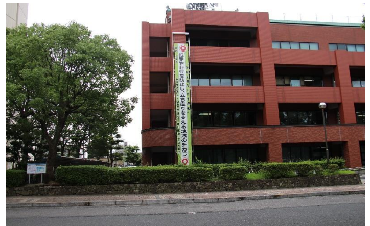
懸垂幕掲揚（西区役所）
